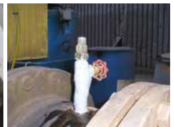
Sellado de fugas de tuberías
