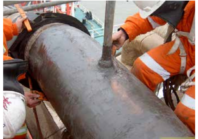
Reparación de tubería de agua caliente e hidrocarburos
