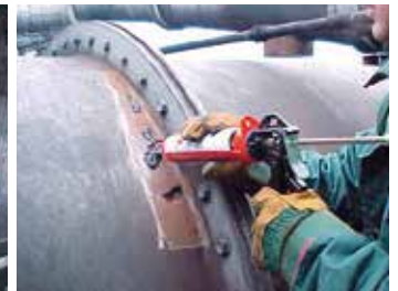
Relleno de picaduras
