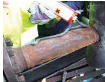
Soldadura de placas
