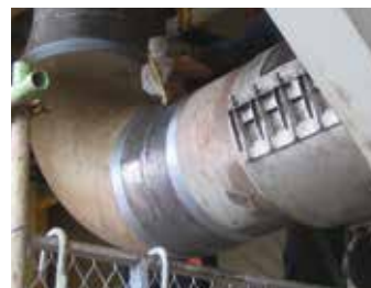
Reparación de soldaduras
