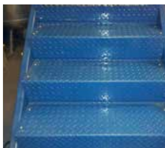
Escaleras de metal antes de la aplicación
