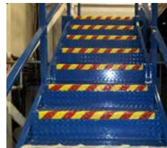
Escaleras de metal después de la aplicación
